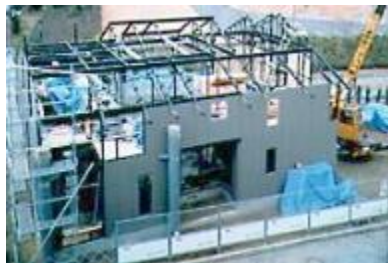
プレハブ(軽量鉄骨)工法
